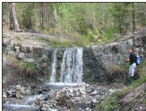
Figure 10 : Exemple de seuils (torrent des Sanières)
